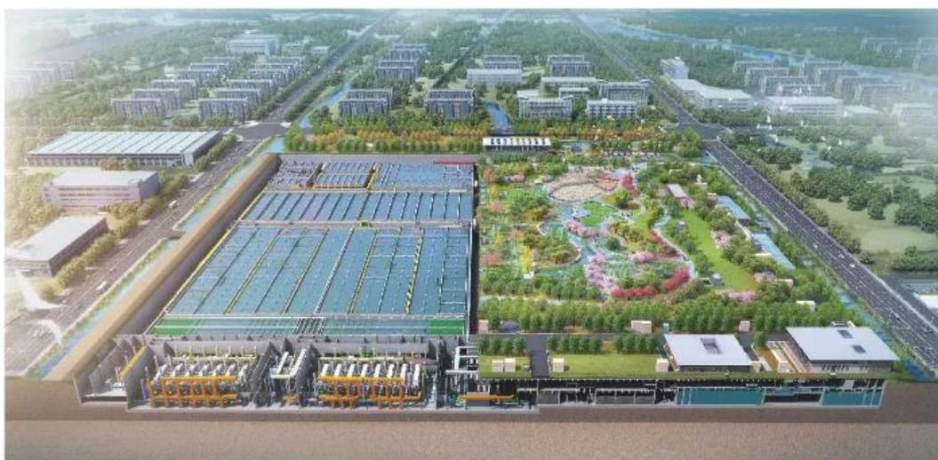
该项目“污泥处理系统集成、供货、调试及伴随服务”由上海复洁环保科技股份有限公司中标并实施，采用“低温真空脱水干化一体化技术”，将含水率 94%~99.3%左右的污泥一次性脱水干化至含水率 40%以下。
