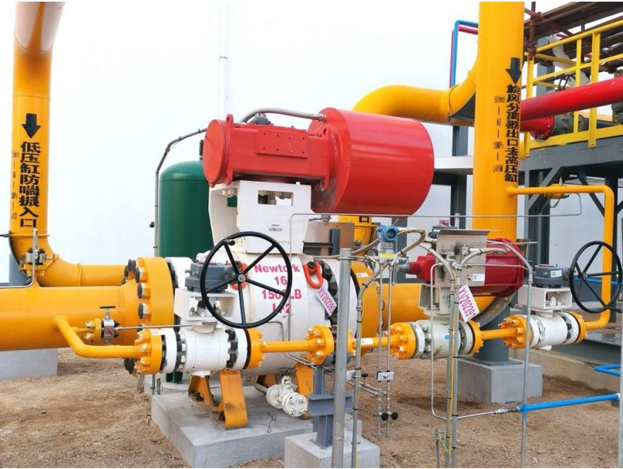
LP 排气、LP-HP 串联、HP 并联切断及加载切断共 88 台套金属硬密封切断球阀，最大规格 NPS20，最高压力磅级 CLASS2500LB。在此次试运过程中，纽托克供货的所有产品均运行良好。
