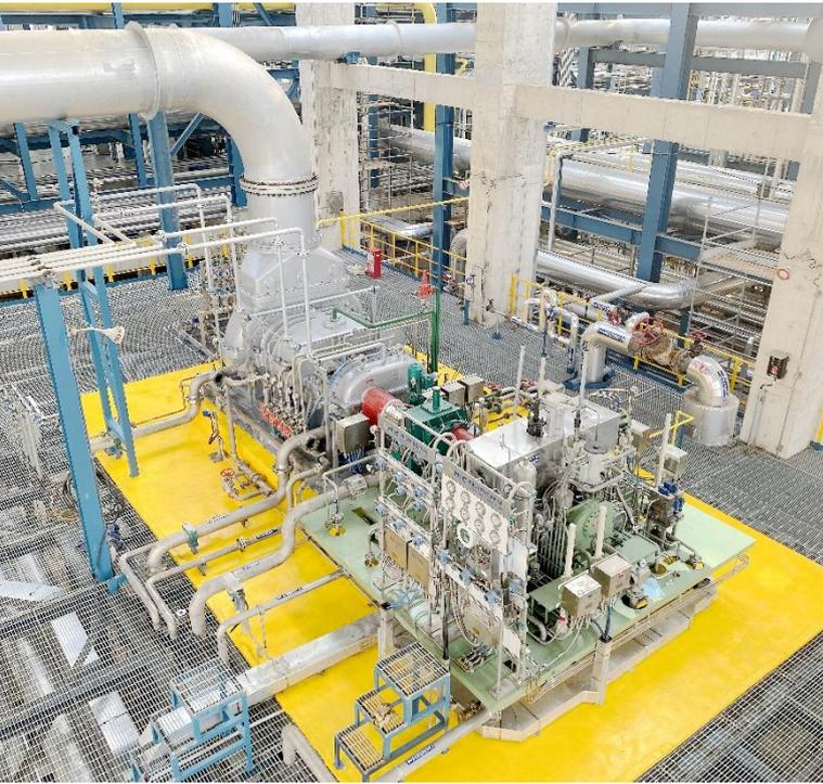
近日，中国船舶集团七一一所与中国石化茂名石化、中国石化上海工程公司联合开发的中国石化重大国产化项目“40万吨/年苯乙烯装置尾气压缩机”，在茂名石化现场成功投产。这是国内首台特大型高温苯乙烯装置尾气螺杆压缩机。
