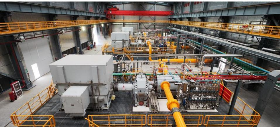
11月6日，国家管网川气东送野三关压气站三套离心式压缩机组（H3164，PCL502）连续72小时试运行考核合格，标志着野三关增压工程顺利投产，川气东送管
